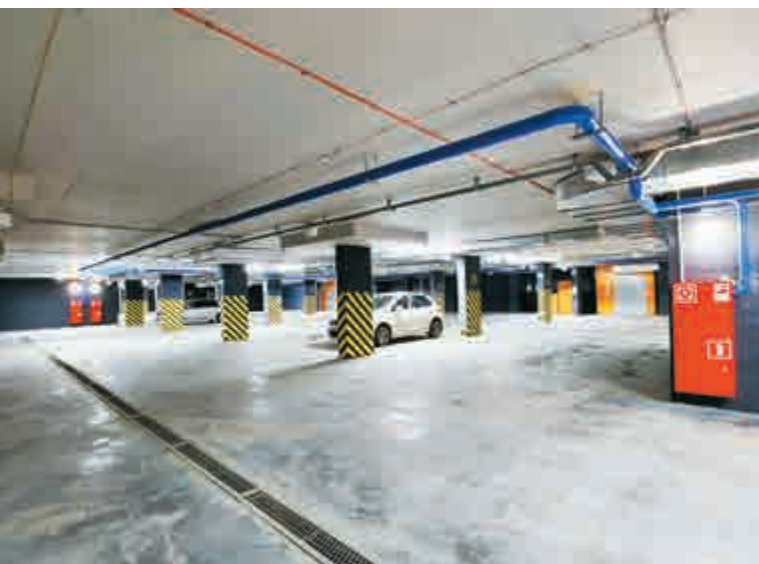
Барнаул ЖК «Апельсин». Подземный паркинг
